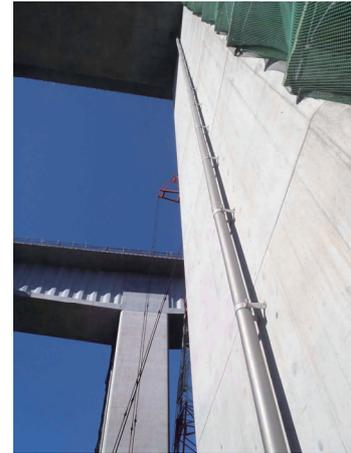
写真-4 橋脚への排水管設置状況
