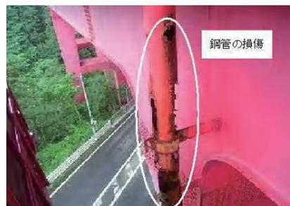
写真-3 鋼管の損傷
