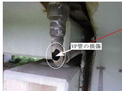
写真-2 VP管の損傷
